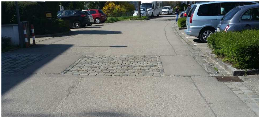
Ausführung in der Gröbmühlstraße
